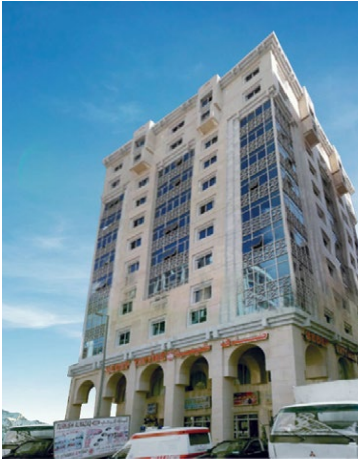
bâtiment waqf du Centre de recherche de Médine
