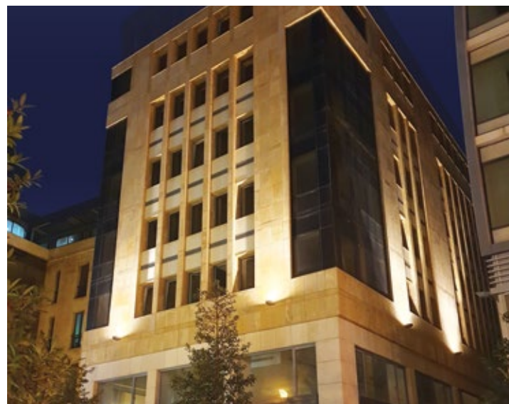
bâtiment du centre Bazerkan après achèvement du projet.
